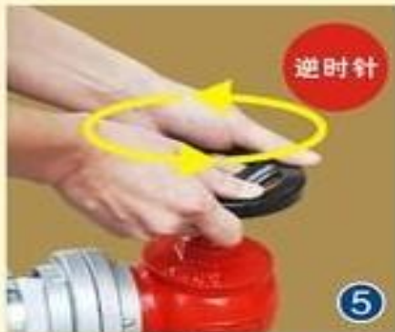
5 打开消火栓上的水阀开关
